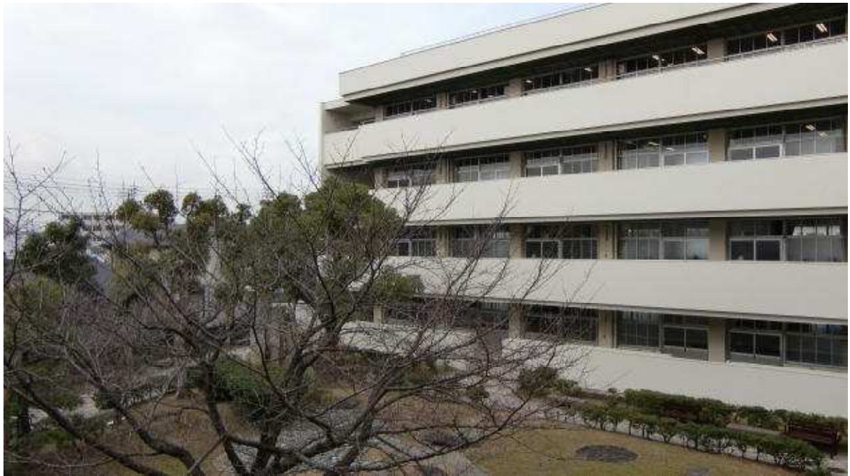
・校舎外壁の塗装
